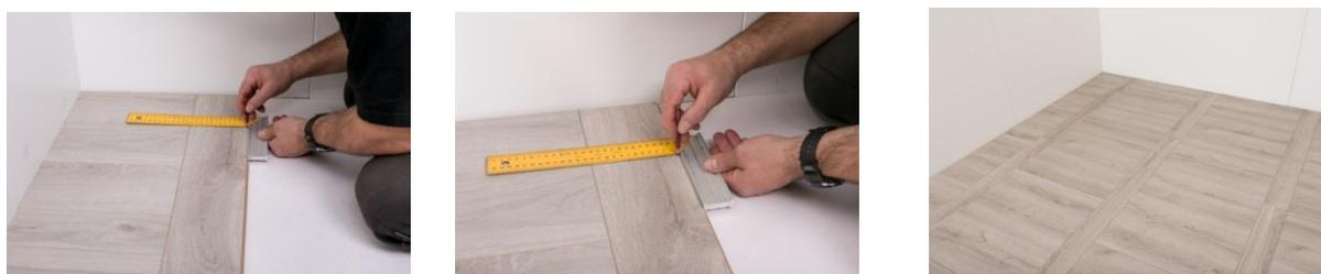
▪ **Le démontage en pose en échelle avec le clip 5G**
